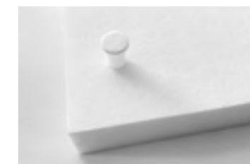
Wandabstandshalter am unteren Ende der Platte
