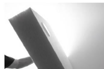
Montage mit Heiß- und Montagekleber
